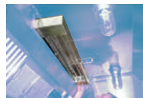
カセット方の UV ランプを フード内へ差込んで設置
